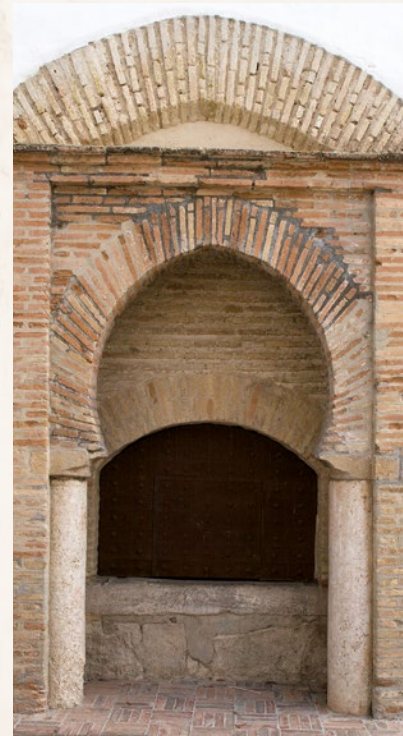
Aljibe de San Miguel Bajo Cistern of San Miguel Bajo
